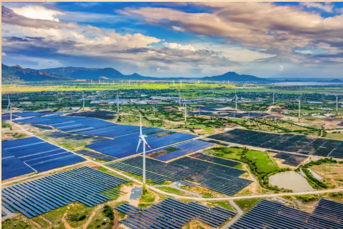
Điện mặt trời tại tỉnh Ninh Thuận.
